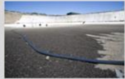
Discarica rifiuti pericolosi
